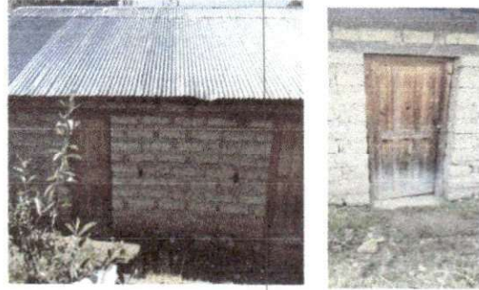
Foto 2: RENGLON 2. sustitucion de puerta
