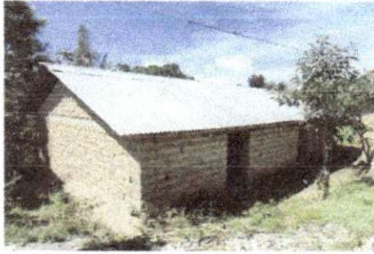
Foto1: RENGLON 1. CUBIERTO DE LAMINA. Sustitucion de lamina
