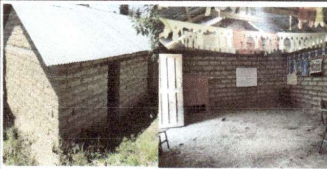
Foto 3: RENGLO 21 Repello y cernido en muro
